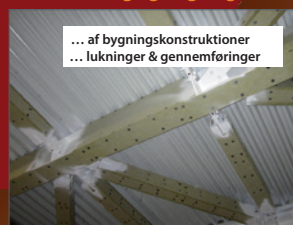
Brandisolering og -fugning
